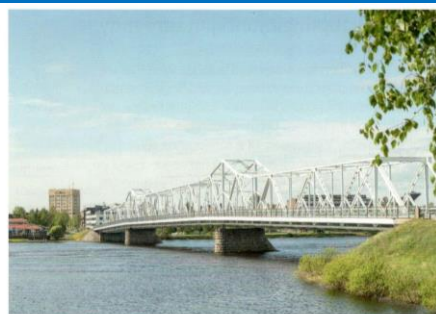
Kuva: Tornion kaupunki
